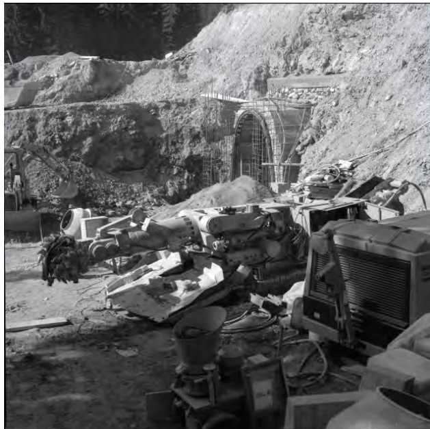
Avanza, 1986. L'imbocco della galleria Mulazzani e la "talpa" di scavo della Finsepol al tempo dell'inaugurazione dei nuovi lavori in Avanza (negativo gelatina ai sali d'argento/pellicola - Archivio Gino Del Fabbro, Forni Avoltri).
