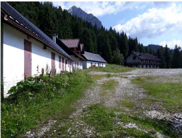
2021. Il panorama un po' spettrale di quello che negli anni '90 del secolo scorso fu un autentico villaggio, a 1700 m di quota, per gli operai della miniera di Avanza. Provvisto di cucine, mensa, dormitori e servizi vari, ora attende che la natura faccia il suo corso.
